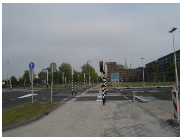
Figura 5.10. Cruce seguro mediante distintos sistemas de regulación e separación de tránsitos (Fonte: TERRAVANZA)
