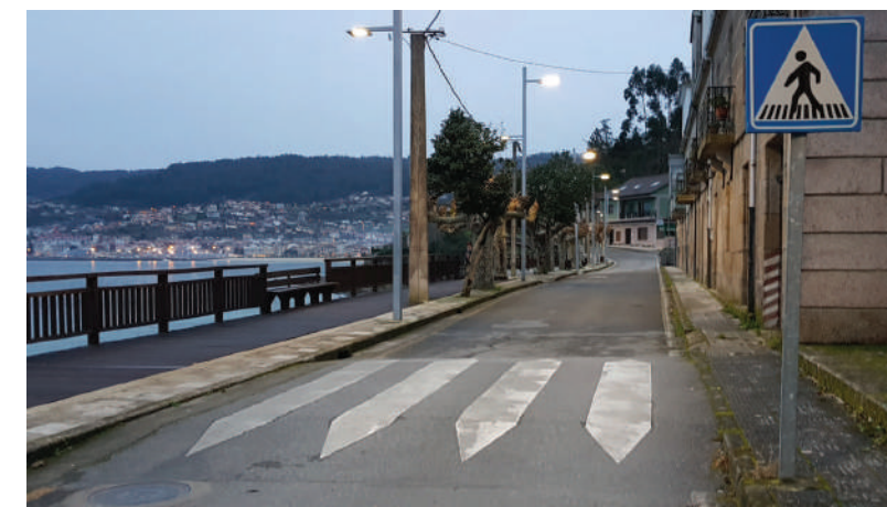
Figura 5.86. Supresión de barreiras arquitectónicas e mellora da accesibilidade nun rúa mediante un paso peonil elevado (Fonte: TERRAVANZA)
