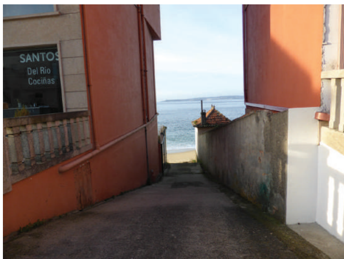
Figura 5.80. Acceso Peonil á Praia Loureiro (Fonte: TERRAVANZA)
