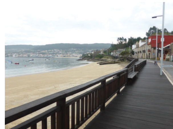
Figura 5.3. Paseo da Praia de Beluso (Fonte: TERRAVANZA)
