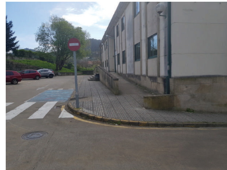
Figura 5.90. Rampla no Centro de Saúde de Bueu para facilitar o acceso (FonteTERRAVANZA)
