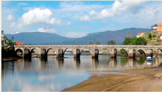
PONTE ROMANO SAMPALCO
